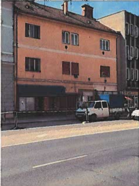
Északi homlokzat (Kazinczy tér)
