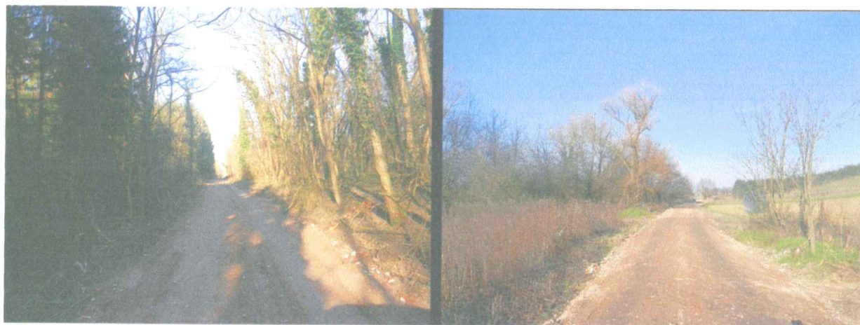
Inert hulladékból helyreállított út a 1049/36 hrsz-on (Bozsoki városrész, Mező utca folytatása déli irányban)
