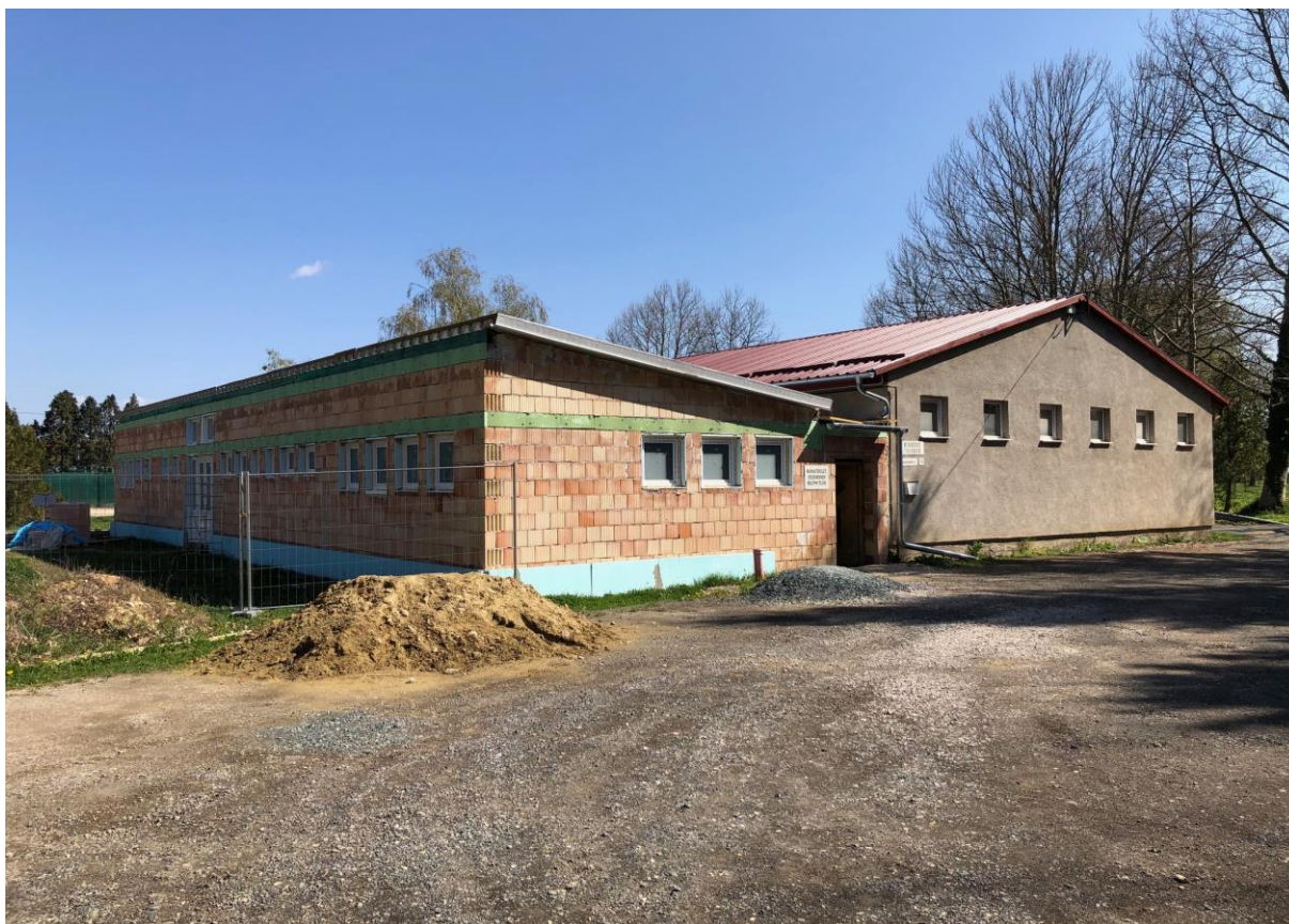
a birkózócsarnok felújítása, bővítése
