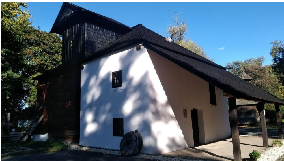
A felújított Hencz-malom
