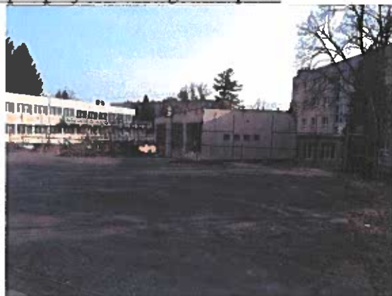
Kollégiumi épület DK-i oldal
